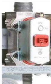
Газовый клапан получает сигнал от платы управления, для изменения параметров.
